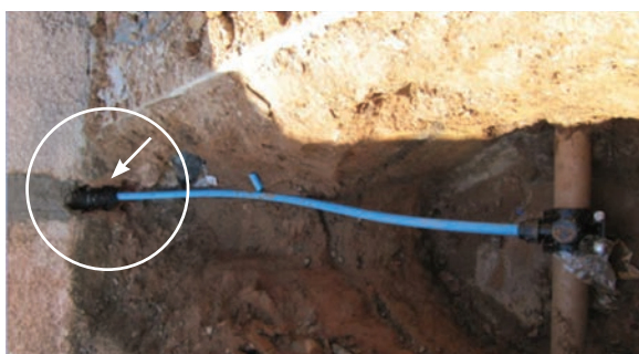
Figura 3 – Detalhe do encamisamento do ramal na parte vertical, utilizado na Sabesp
