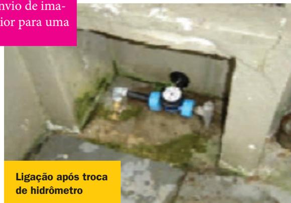
5. Retirada do kit de medição e substituição do hidrômetro local. Após uma semana de medições, o kit é retirado e o hidrômetro do usuário é substituído e levado a laboratório para levantamento de sua curva de erros em bancada padronizada. A retirada dos hidrômetros deve ser feita de forma cui-
