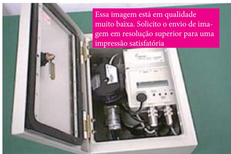
**4.** Realização das enquetes e instalação dos kits de medição. Com toda a logística pronta, vai-se a campo para a realização das entrevistas com os usuários, obtenção de permissão instalar os equipamentos e coleta dos dados. Os equipamentos precisarão ficar em local abrigado e não sujeito a vandalismo ou furto. Todas as instalações deverão ser fotografadas. O kit de medição é instalado em série com o medidor do usuário.
