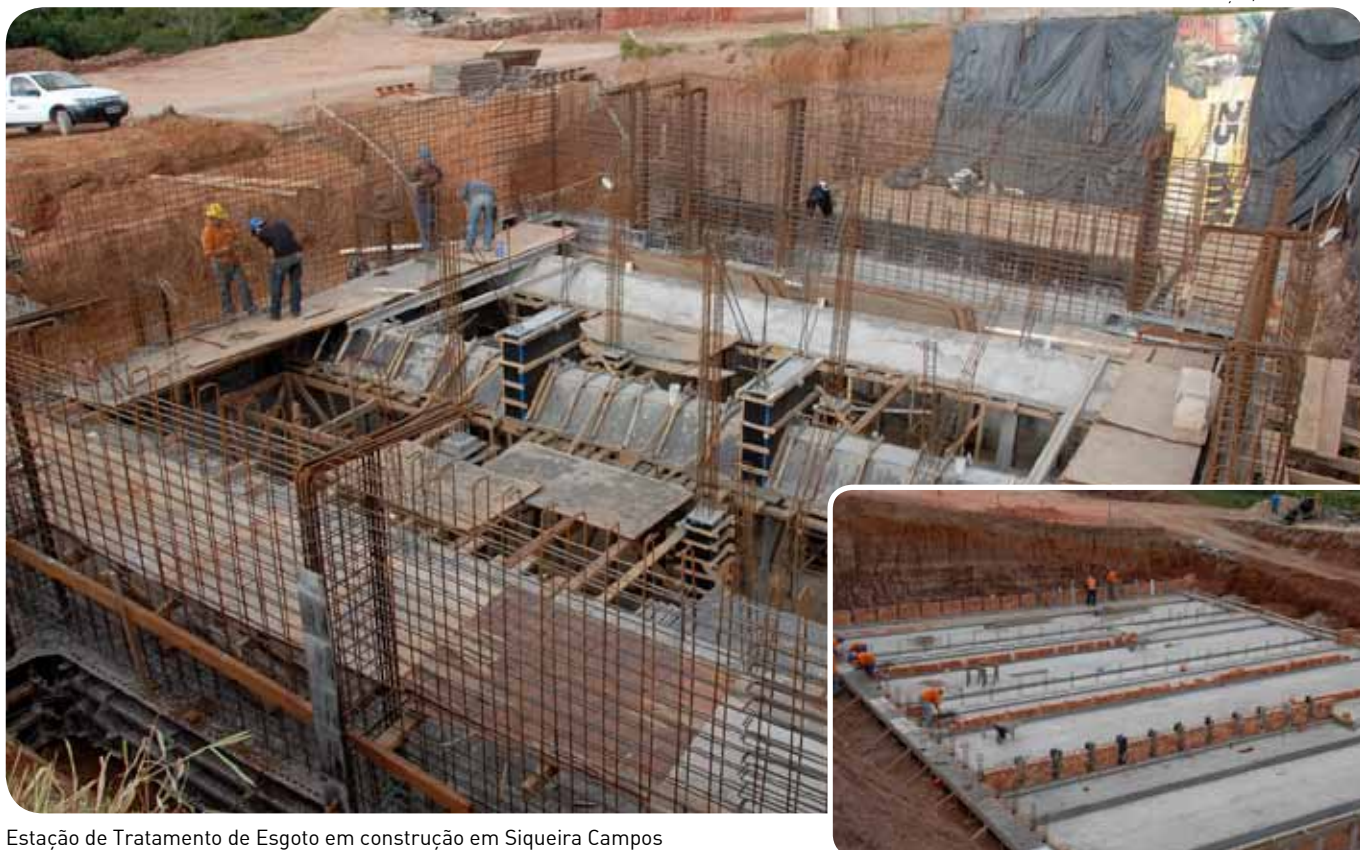
Leitos de secagem do lodo de esgoto da nova ETE de Siqueira Campos
