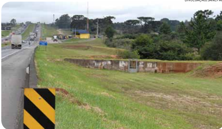
No Paraná, a Sanepar construiu caixas de contenção para evitar que produtos químicos, transportados nas rodovias, contaminem os mananciais próximos
