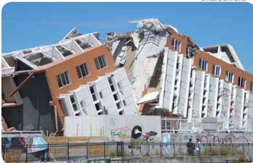
Terremoto de 8,8 graus de magnitude derrubou prédios e vitimou centenas de pessoas no Chile, no ano passado
