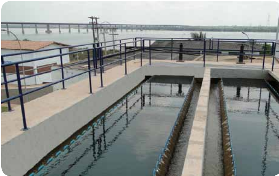
Primeira etapa da Estação de Tratamento de Água - ETA Marabá
