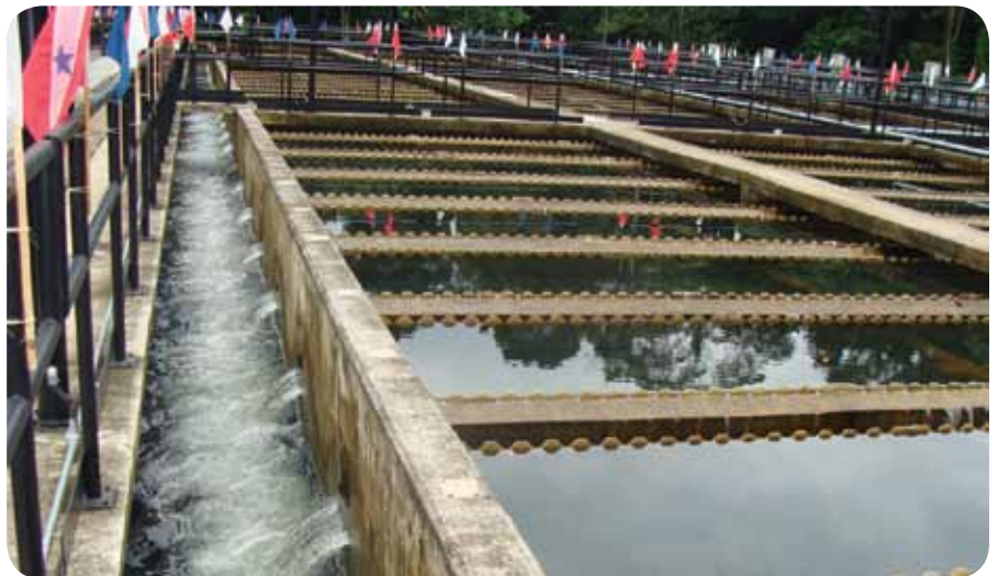
Segunda fase da Estação de Tratamento de Água - ETA Bolonha
