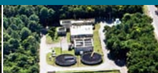
Estação de Tratamento de Esgoto Sanitário Barra da Lagoa – Florianópolis.
