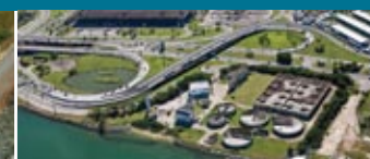
Estação de Tratamento de Esgoto Sanitário Insular – Florianópolis.
