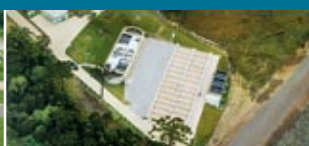
Estação de Tratamento de Esgoto Sanitário – São Joaquim.
